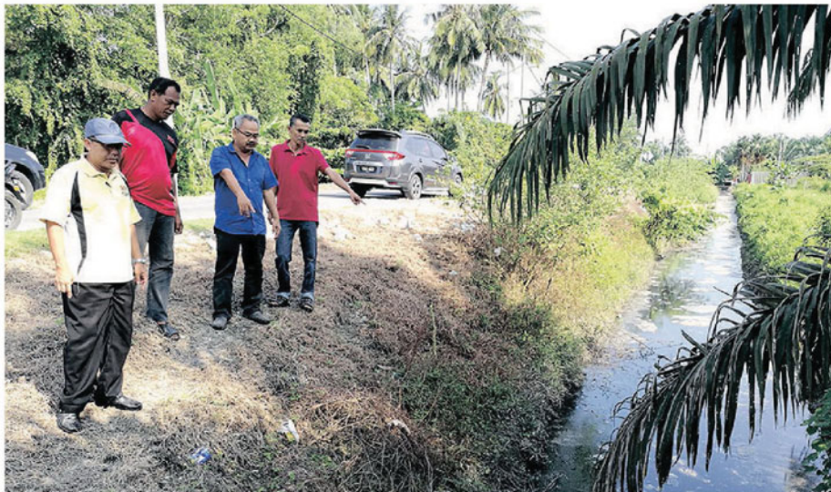
Hazri (kiri) bersama penduduk melihat sisa kumbahan kilang yang mengakibatkan air parit busuk dan menjejaskan ternakan kerang.
